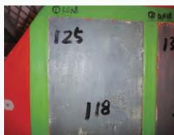
塗膜はく離作業完了後、再塗装する塗料に適する素地調整程度(グレード)を検討してください。鋼板面の凹部に残存する塗膜が有る場合、除去法を検討してください。
