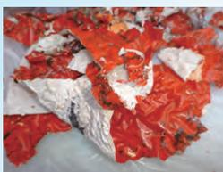
はく離回収した塗膜は湿潤シート状態で回収できます。塗膜に含有する有害物質の飛散、拡散が低減できます。
